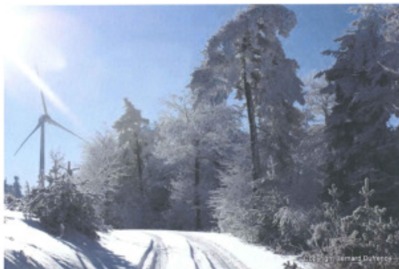
Photographie 51. Parc éolien de Laprugne en France (8 E-62 E1 85 m)
