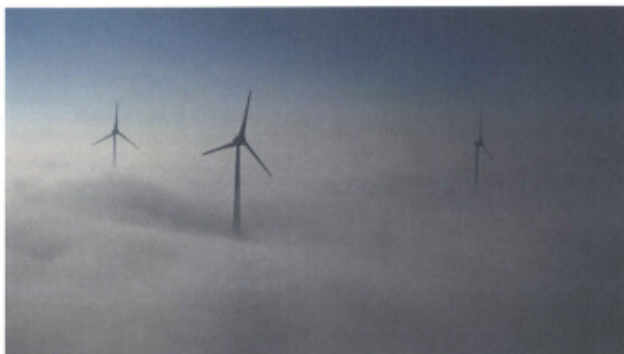
Photographie 4. Parc éolien d'Estinnes en Belgique (11 E-126 135 m)
