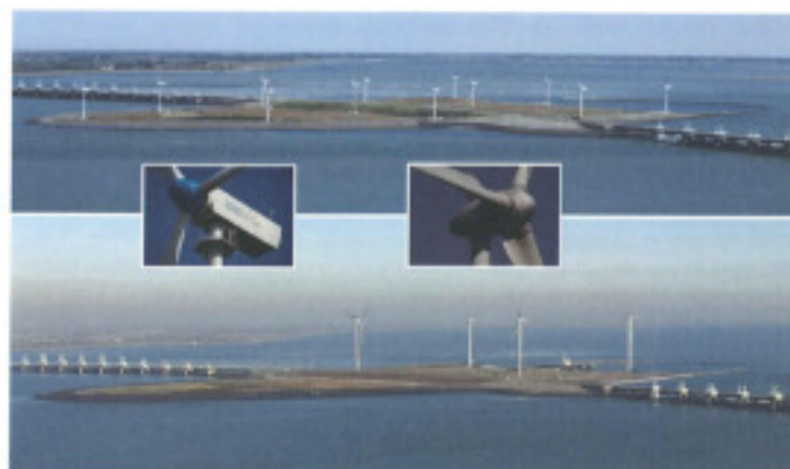
Photographie 1. Renouvellement (repowering) du parc éolien de Roggeplaat aux Pays-bas (remplacement de 12 E-33 35 m par 4 E-82 E2 78 m)
