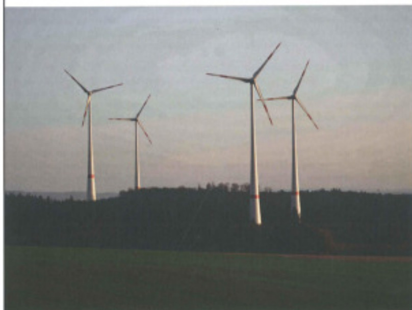
Photographie 36. Parc éolien de Kirchberg en Allemagne (8 E-82 E2 138 m)
