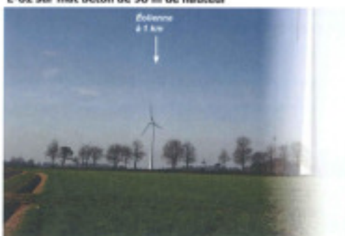
E-82 sur mât béton de 98 m de hauteur
