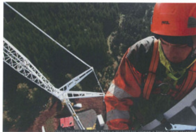
Photographie 8. Vue de la plateforme de grutage depuis la nacelle
