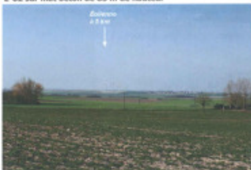
E-82 sur mât béton de 85 m de hauteur
