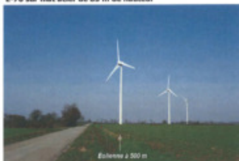
E-70 sur mât acier de 85 m de hauteur
