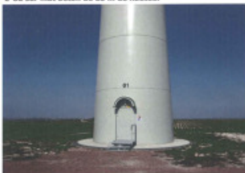
E-82 sur mât béton de 98 m de hauteur
