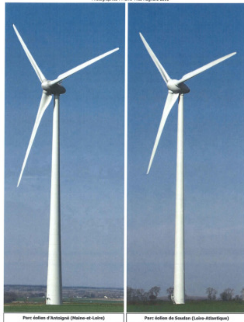
Photographie 45. Différence mât acier / mât béton
