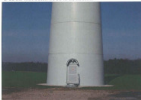
E-82 sur mât béton de 98 m de hauteur
