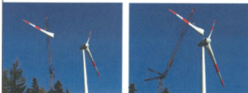
La pale est guidée vers le moyeu...
